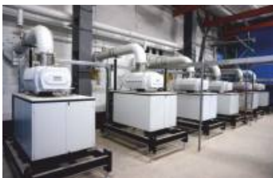
Вакуумная установка электронно-лучевой сварки
